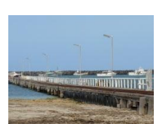
Port MacDonnell Jetty
